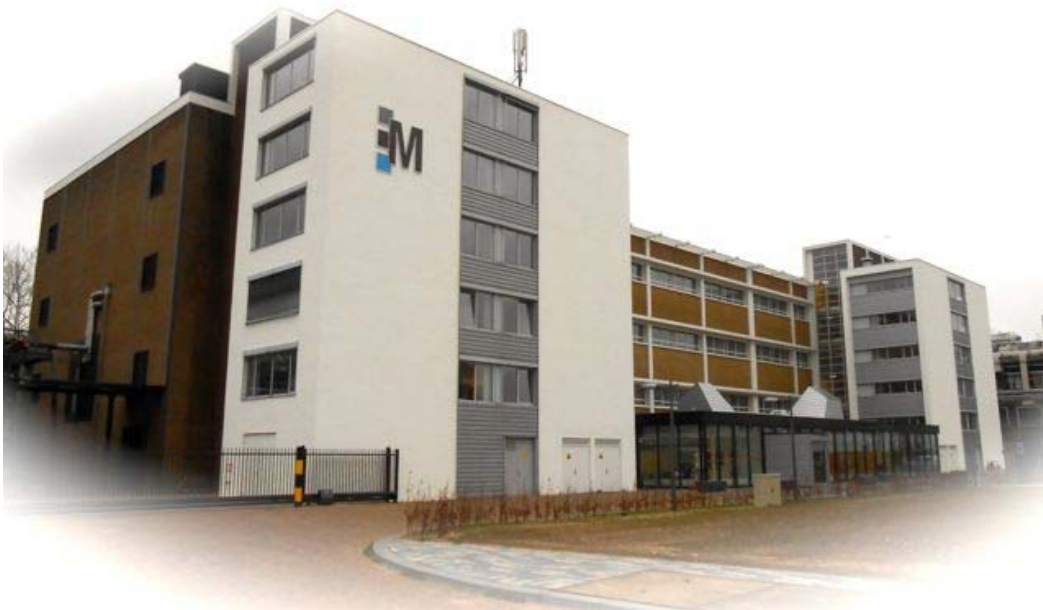
SMB, Novio Tech Campus の施設写真
